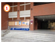
電資大樓一樓玄關北側
