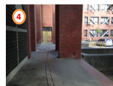
理工學院無障礙坡道上方
